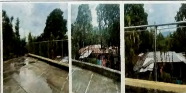
Foto 11: TRABAJOS EXTERIORES Vista de muro de block con tubo HG y malla metálica cal 12
