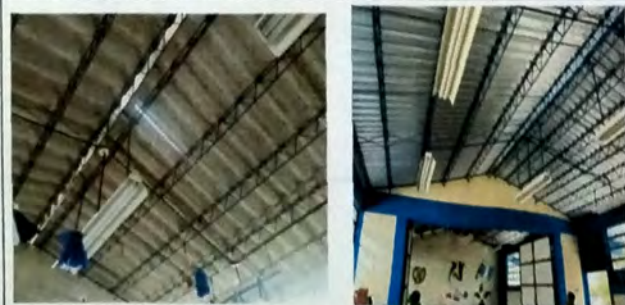
Foto 5: MODULO A Vista interior de mantenimiento de estructura de metal a base de JOIST sustitucion de lamina de asbesto por instalacion de lamina troquelada cal 26.
