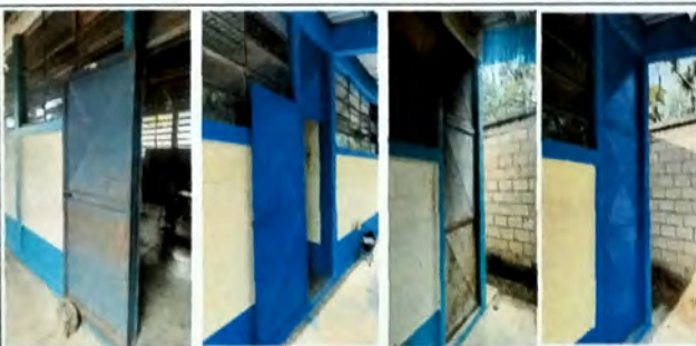
Foto 3: MODULO DE SERVICIOS SANITARIOS. Remozamiento de puertas de metal de aulas.
