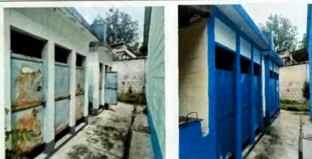
Foto 9: VISTA MODULO DE SERVICIOS SANITARIOS, remozamiento de puertas de metal. Y pintura de paredes
