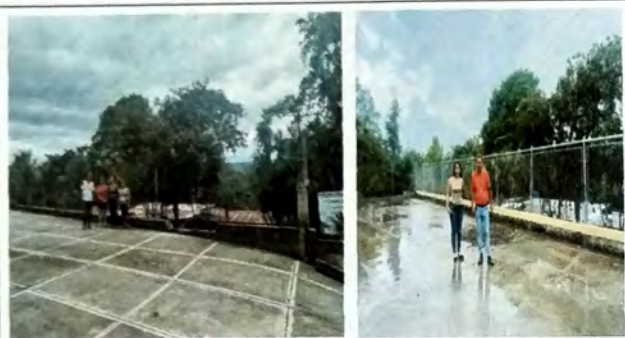
Foto 7: TRABAJOS EXTERIORES Vista de muro de block con tubo HG y malla metálica cal 12
