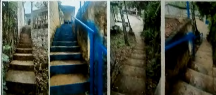
Foto 6: TRABAJOS EXTERIORES. Vista de barande de metal en gradas existentes.
