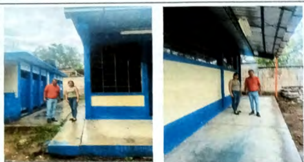
Foto 1: MODULO A Vista exterior y Modulo de servicios sanitarios.
