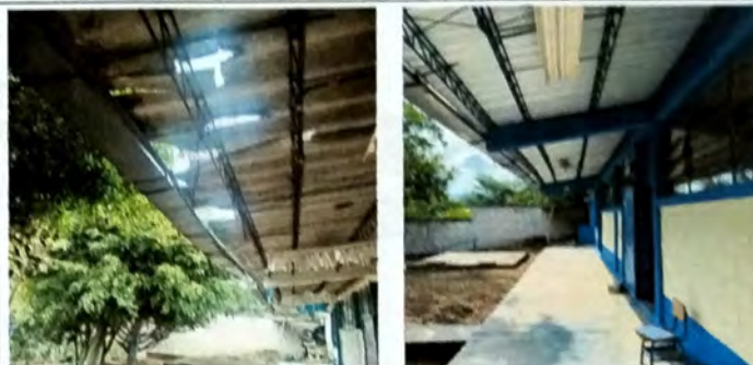
Foto 2: MODULO A vista de corredor exterior, mantenimiento de estructura de metal a base de JOIST sustitucion de lamina de asbesto por instalacion de lamina troquelada cal 26.
