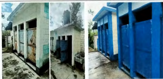
Foto 8: VISTA MODULO DE SERVICIOS SANITARIOS, remozamiento de puertas de metal. Y pintura de paredes
